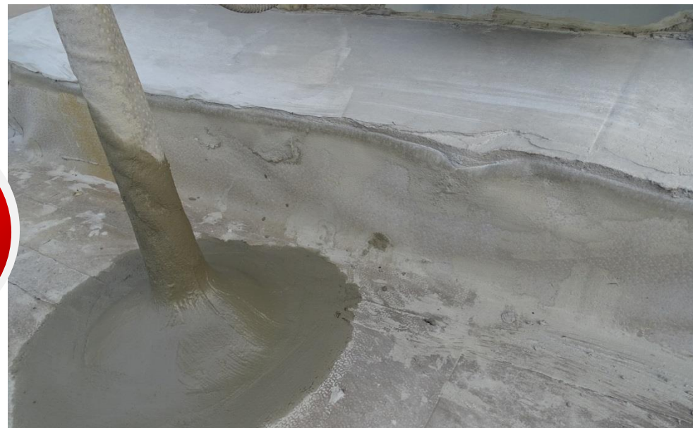
обработано ARENA PolyElast PE в 2 слоя
