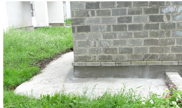
Реконструкция бетонной отмостки вентиляционных шахт
