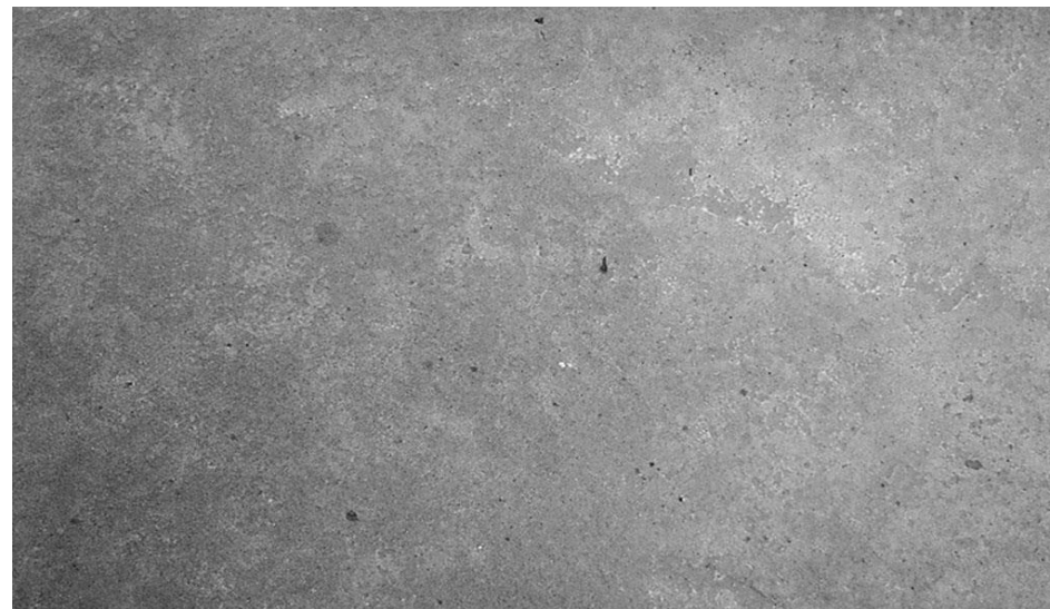
бетон отремонтирован ARENA Repair Master R500
