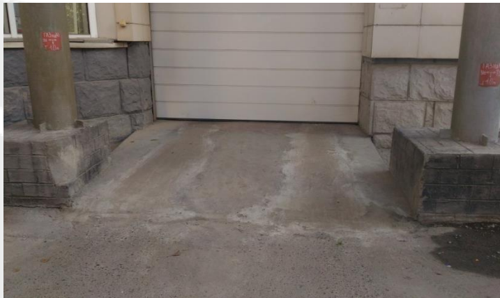
Восстановление покрытия въезда в паркинг
