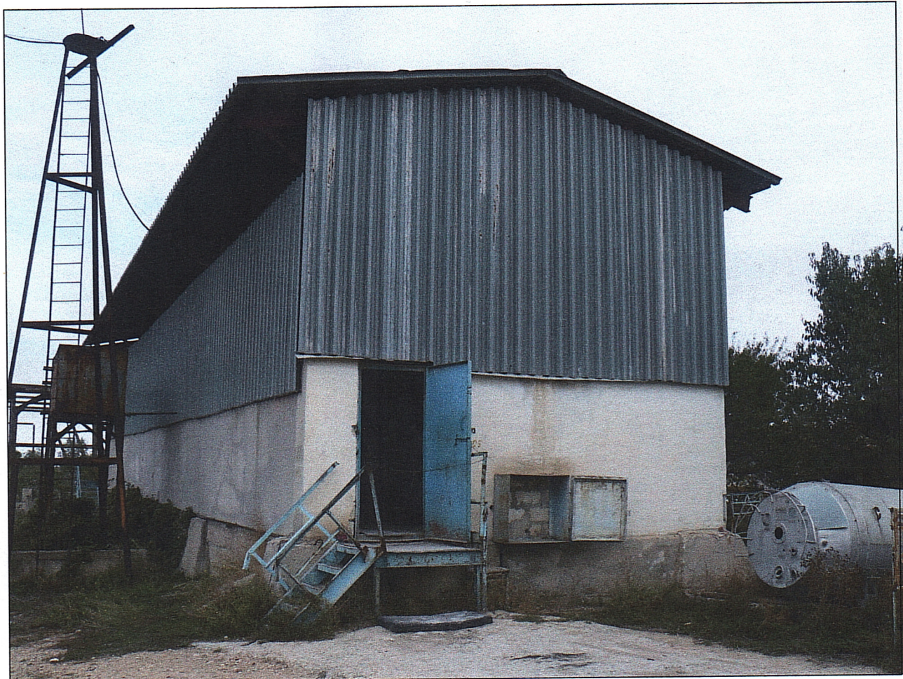
Фото 1. Общий вид со стороны фасада А-Б.
